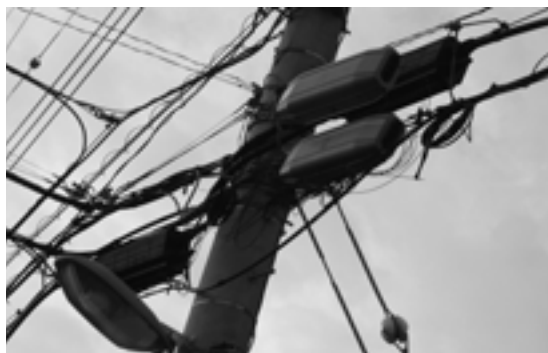
加入者線は1本が1回線で、端子ボックスで分岐している
