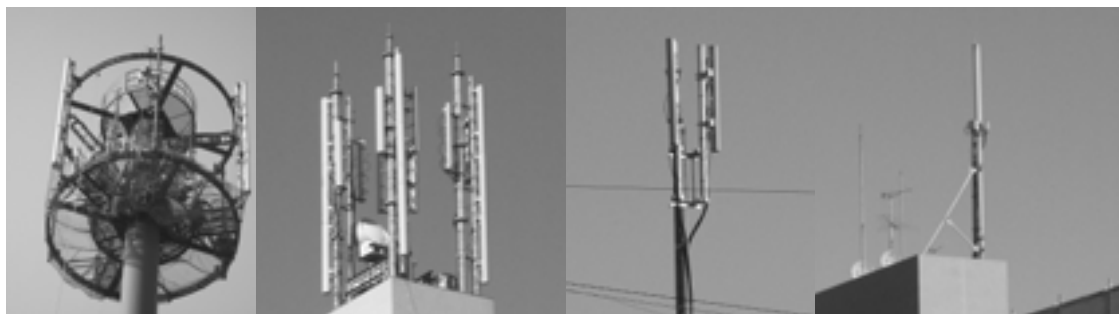
携帯電話の基地局の目印となるアンテナ 電話会社によりそれぞれ異なるが、見分けることは困難。
