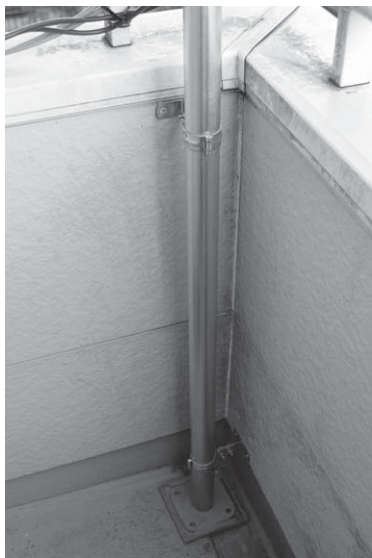
写真1 柱パイプの取り付け ベランダ両端にパイプを立てる。ベランダ内側の壁面に上下2か所で固定。パイプ下端には足場管固定ベースおよびその下にラバーのベースを敷きベランダ床面を保護。
