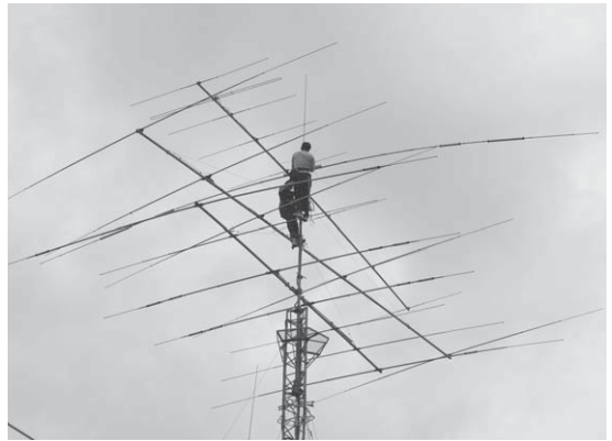
タワーの上、つまり高所での作業は細心の注意をはらい安全に務めるとともに堅牢な施工が求められる。ものを落とさせないほか、ネジ類の締め忘れがないかなど2名でチェックしあうことも時には必要。
