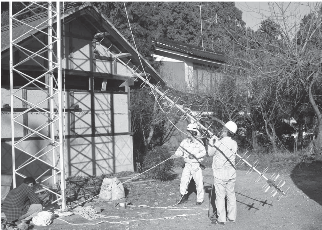
アンテナ工事では地上での準備や補助もその作業効率に影響する。超大型アンテナでなければ人力でも十分に上げ下げは可能。ロープを上手に使い上部の作業者のフォローを行うにもノウハウは少なくない。
