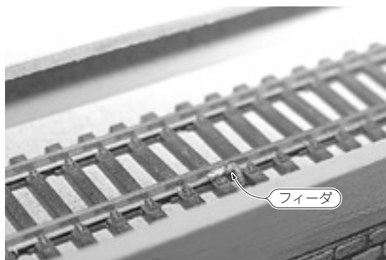
写真1-3 線路にはんだ付けしたフィーダ線(協力:小金井HOクラブ)
