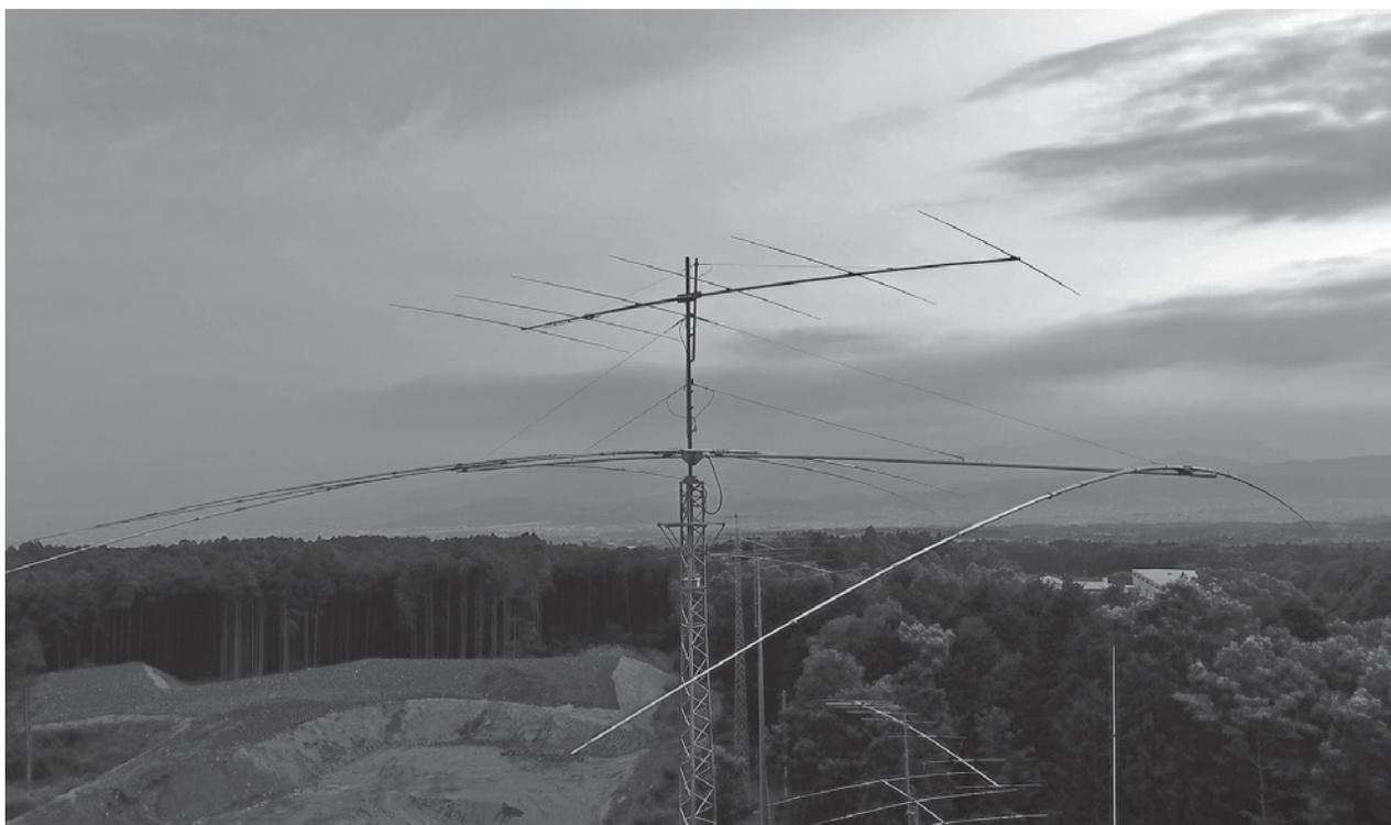
写真3-2 同じ水平方向のアンゲルも, HFローバンドの長いアンテナの場合は, 自重でしなっているの, それなりに存在感のある写真になる
