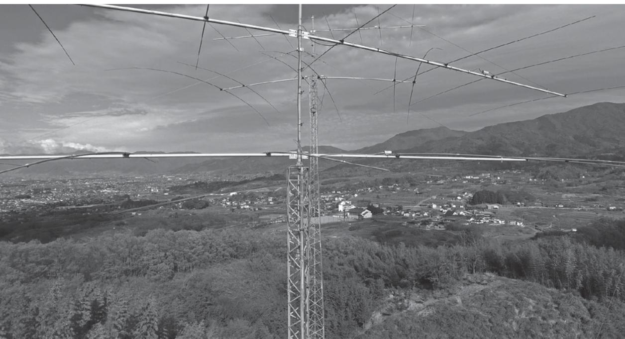
写真3-4 1本のマストに2枚の八木アンテナが設置されている場合
