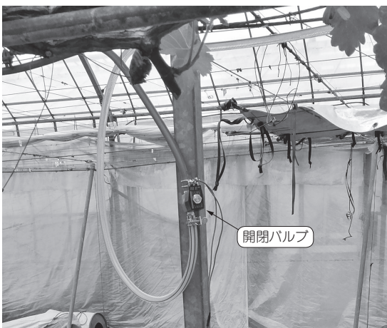
写真4 ソレノイドで動作する開閉バルブ
