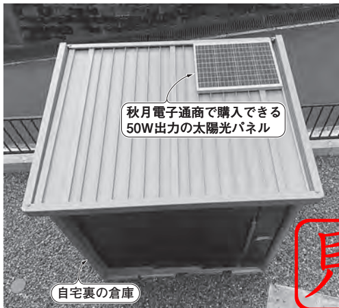
(a) 倉庫の屋根に太陽光パネルSY-M50W-1を設置した。場所に余裕があるため、大きめのパネルを平置きしている
