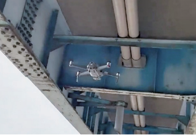
写真1 橋の構造体を間近で撮影してクラックなどの発見に利用されるドローン
